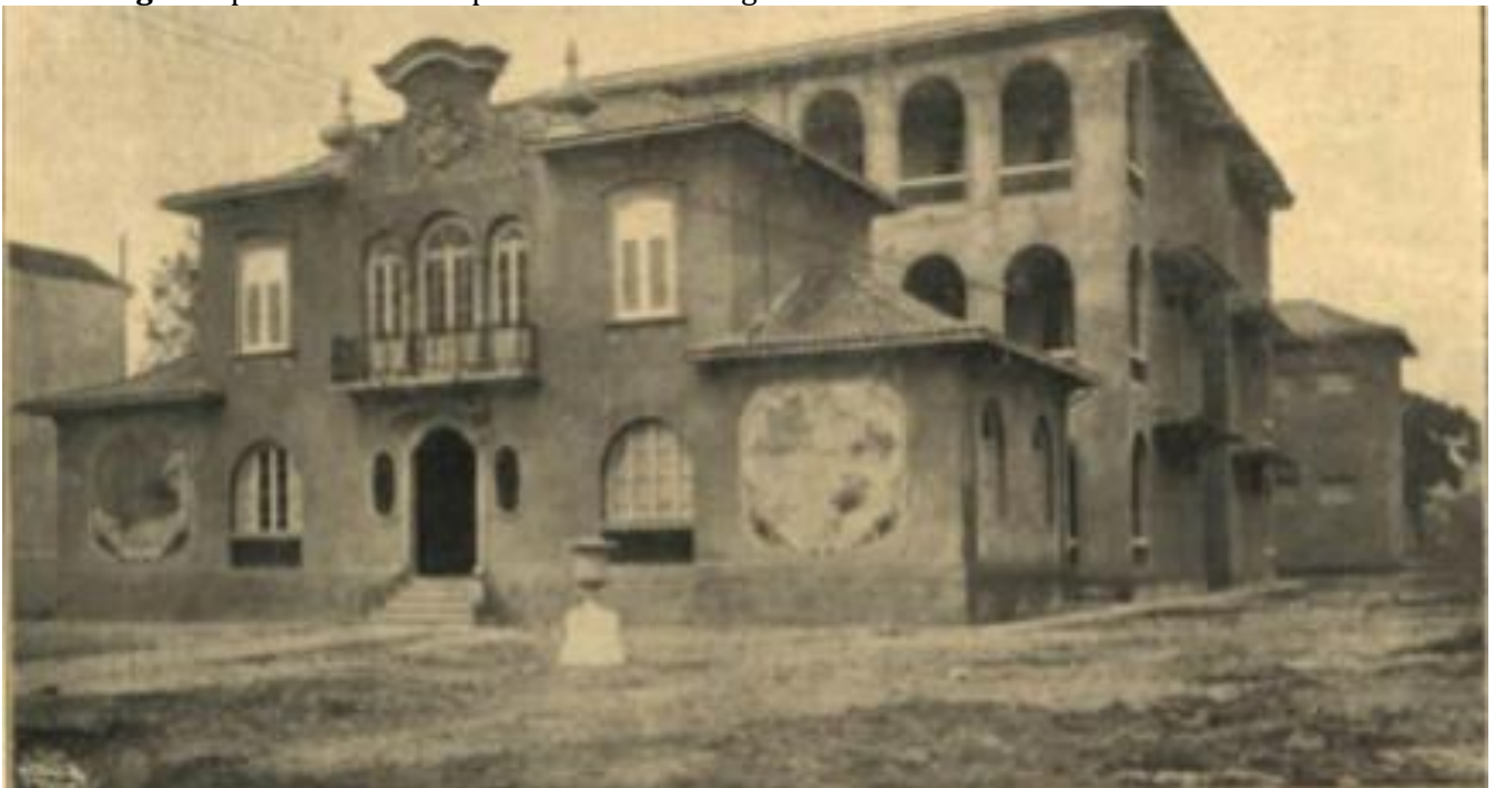
Fig 2: Aspecto externo do prédio da Escola Argentina
